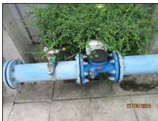
รูปที่ 1-4 ระบบท่อรับน้ำประปาจาก กปน.ด้านหน้าโครงการ
